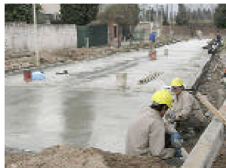
Trabajos de pavimentación en Villa Constructora.
