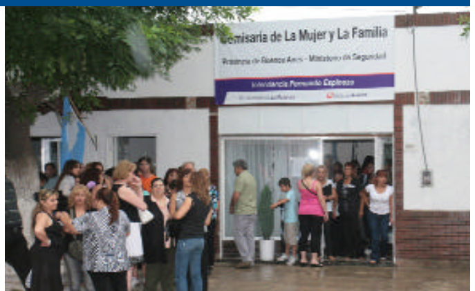
Las nuevas instalaciones de la Comisaría en Virrey del Pino.
